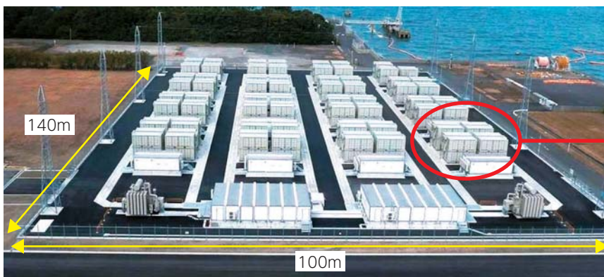
豊前蓄電池変電所(福岡県豊前市) NAS電池®(ナトリウム・硫黄電池)コンテナ252台
