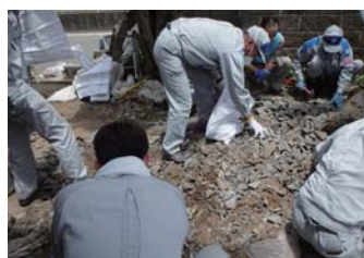
割れた瓦の撤去作業
