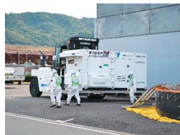
電源供給訓練 (可搬型電源の設置)
