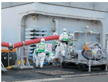
冷却水供給訓練 (可搬型電動注入 ポンプの設置)
