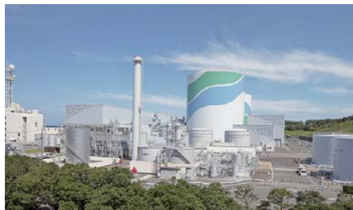
川内原子力発電所
