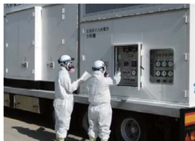
緊急時対応訓練(電源復旧訓練)
