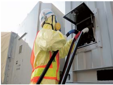
電源供給訓練 (中容量発電機車の 電源ケーブル接続)
