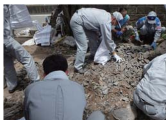
▲割れた瓦の撤去作業
