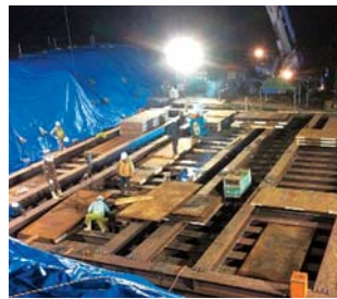
(仮鉄塔基礎工事)
