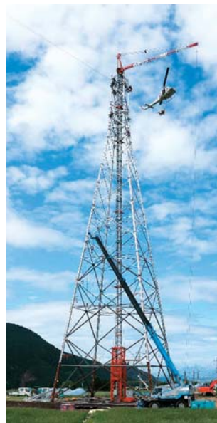
仮鉄塔架線作業
