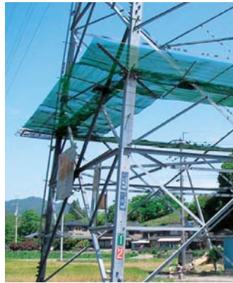
送電鉄塔への昇塔防止装置の設置
