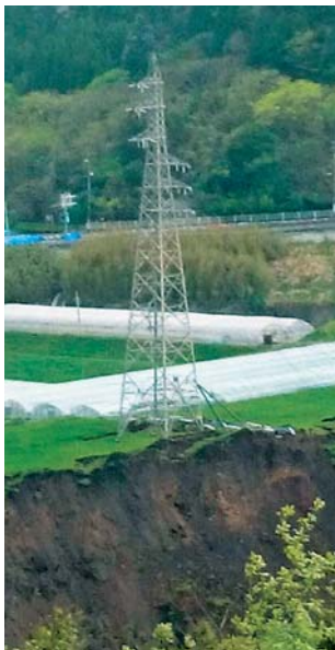
鉄塔被害状況
