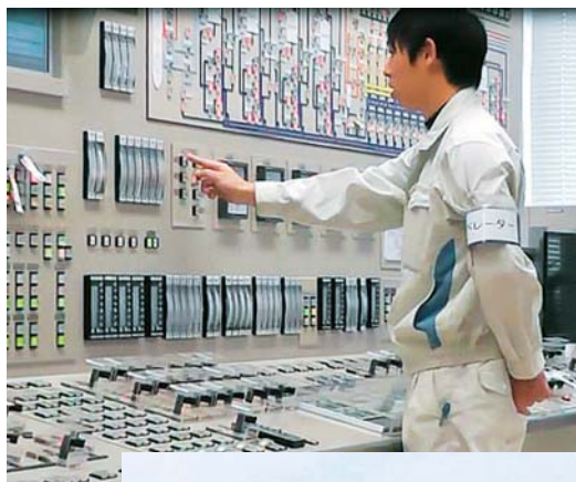
中央制御室の遠隔操作で棧橋とLNG船をつなぐロープを切り離す様子
