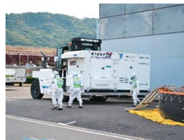
電源供給訓練 (可搬型電源の設置)
