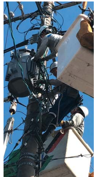
配電線復旧作業
