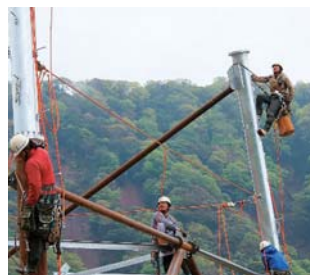
仮鉄塔建設作業
