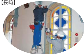
頭ヶ島天主堂（重要文化財）の配線点検
