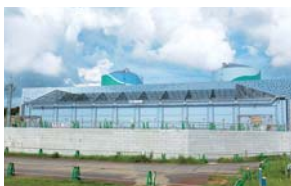
海水ポンプエリア周辺の防護壁
