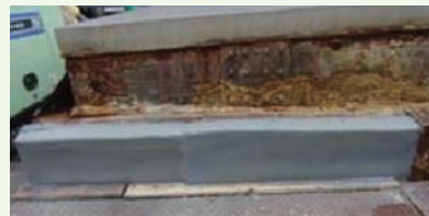
モルタル補修材による仕上がり状況【補修後】
