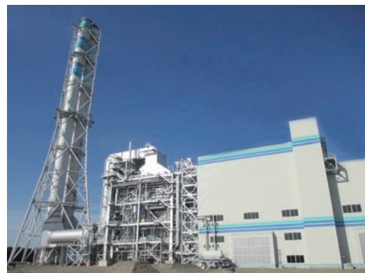
新大分発電所3号系列第4軸(LNG火力)
