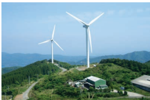
長島風力発電所
