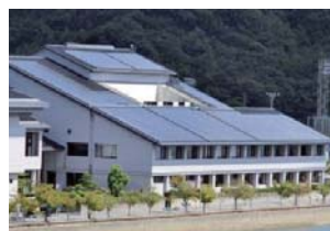
太陽光パネル(屋根設置)
