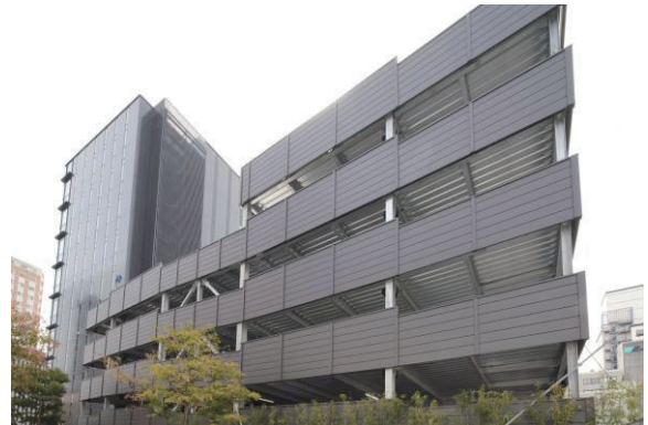
自走式立体駐車場
