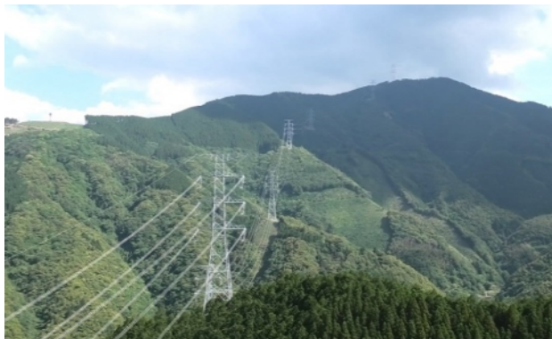
〔宮崎県木城町 No.271 鉄塔付近〕
