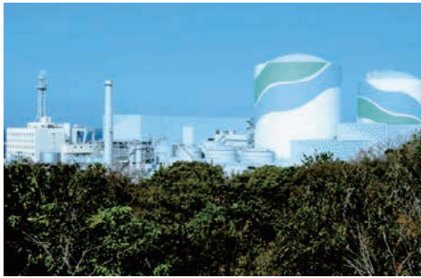
CO 2 排出抑制に貢献する川内原子力発電所(鹿児島県)
