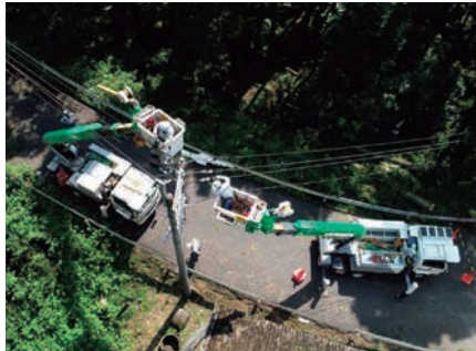
復旧作業の様子
