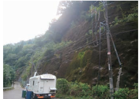
高圧発電機車による応急送電
