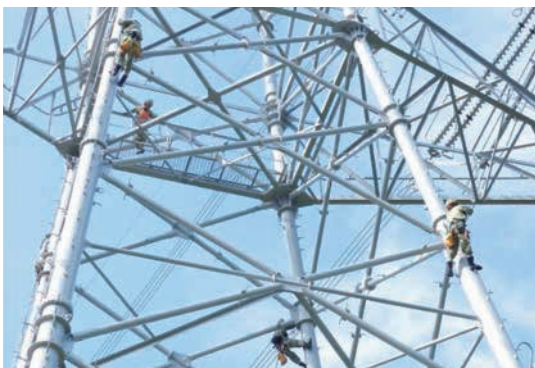
送電鉄塔の設備点検
