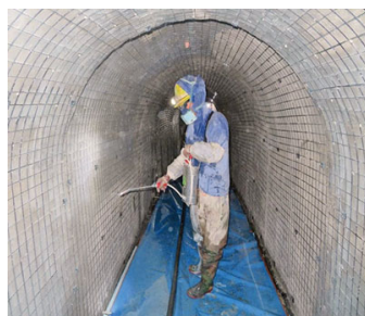
図2 現場実装の様子
