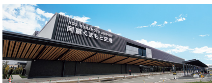
熊本空港特定運営事業（新旅客ターミナルビル） （2023年3月供用開始）
