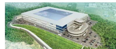
福岡県粕屋町物流施設事業 （2024年8月運用開始予定）
