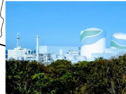
川内原子力発電所
