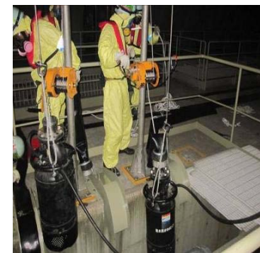
取水用水中ポンプの設置訓練
