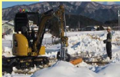
無線重機訓練
