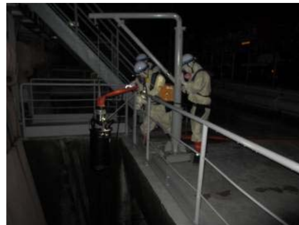
取水用水中ポンプの設置訓練
