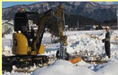
無線重機訓練
