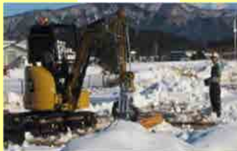
無線重機訓練
