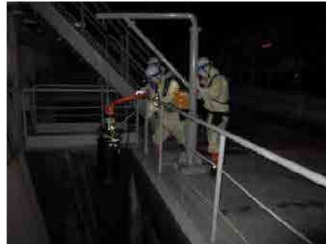
取水用水中ポンプの設置訓練
