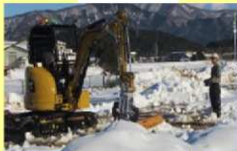
無線重機訓練
