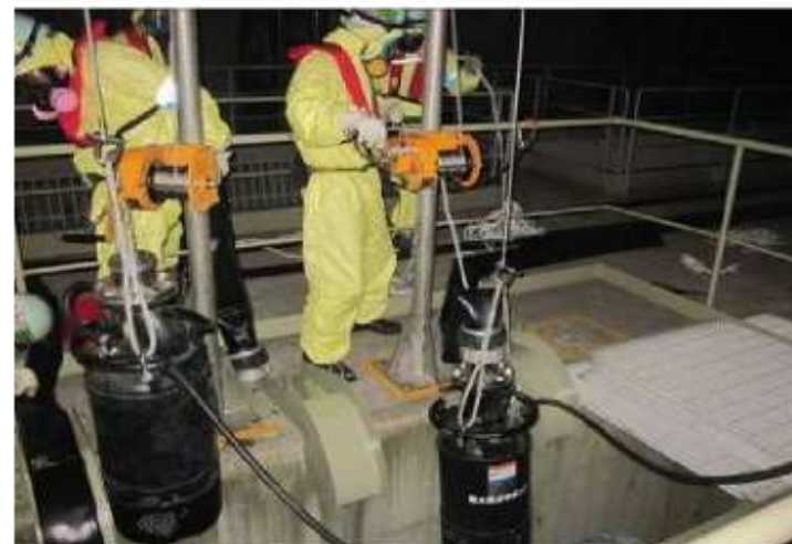
取水用水中ポンプの設置訓練
