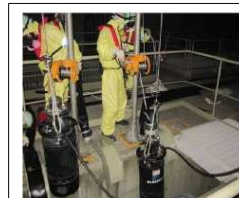
取水用水中ポンプの設置訓練
