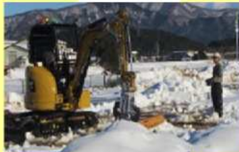
無線重機訓練
