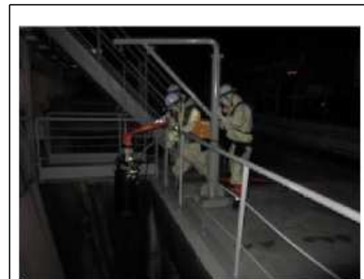
取水用水中ポンプの設置訓練
