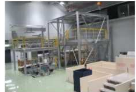
事務所棟 訓練施設
