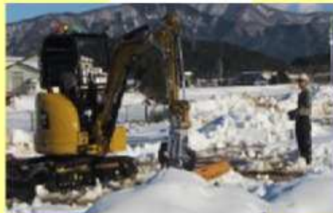
無線重機訓練
