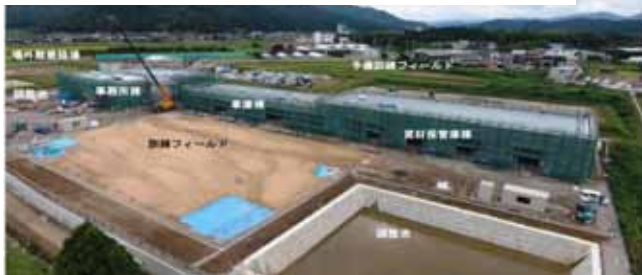
現地工事進捗状況(2016年9月27日)
