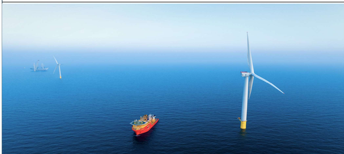
写真提供元：Dogger Bank Wind Farm
