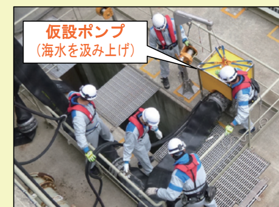
移動式大容量ポンプ車や仮設ポンプを用いて、原子炉等を冷却するための水を供給
