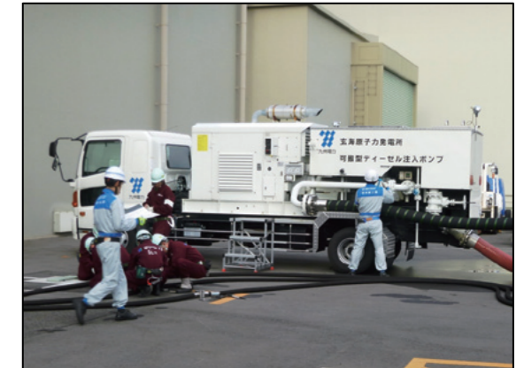
可搬型ディーゼル注入ポンプを使った冷却水の確保
