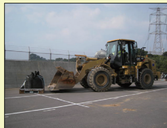
津波で発生したがれきを撤去し、資機材等の運搬ルートを確認
