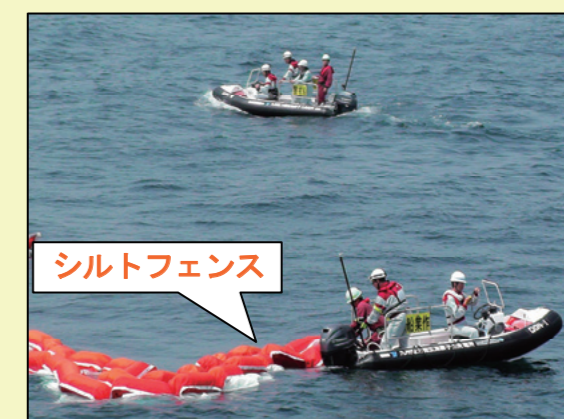
放射性物質の海洋への拡散を抑制するためのシルトフェンスを設置
