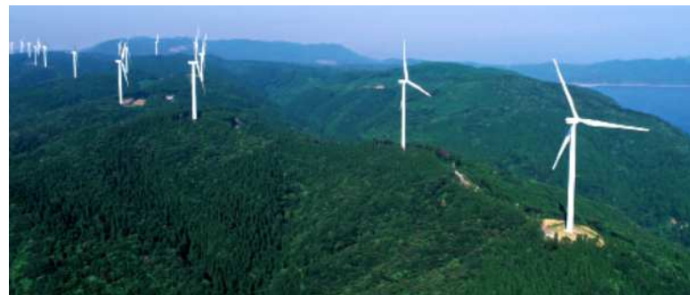
串間風力発電所
