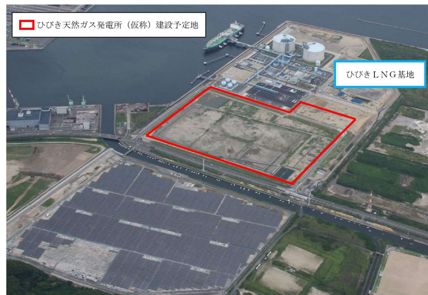
[ひびき天然ガス発電所(仮称)建設予定地全景]
