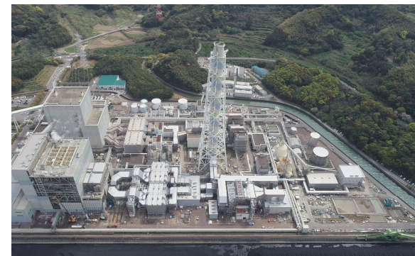
▼ 松浦発電所2号機の全景写真
