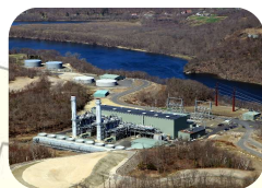
② クリーンエネルギーガス火力発電所
