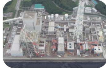
【建設中の松浦発電所2号】
