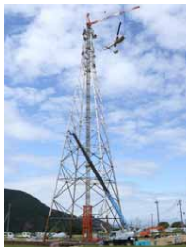
仮鉄塔架線作業
