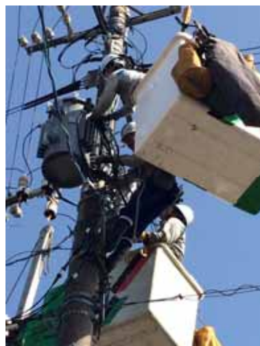
配電線復旧作業
