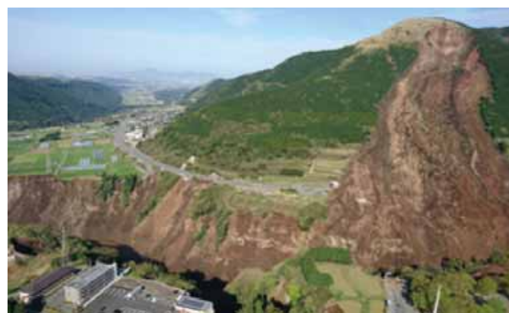
大規模な土砂崩れ（熊本県南阿蘇村）
