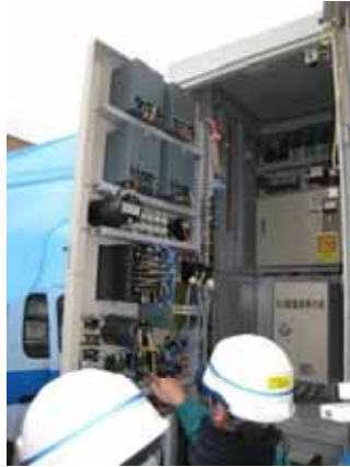
配電塔の現場点検
