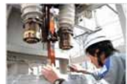
遮断器の点検・修繕
