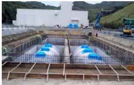
非常用ディーゼル発電機の 燃料油貯蔵タンク増設
