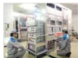
保護装置の点検・修理・試験
