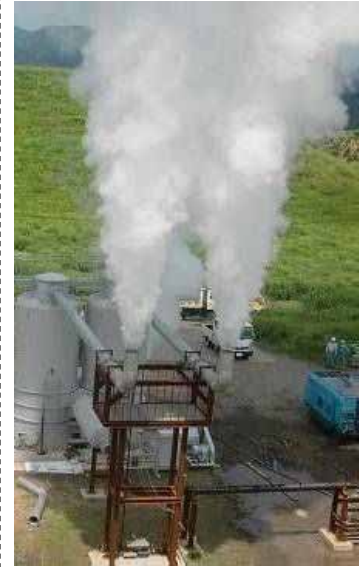
〔菅原バイナリー発電所 井戸噴出試験の様子〕
