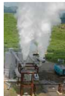
菅原バイナリー発電所 井戸噴出試験の様子
