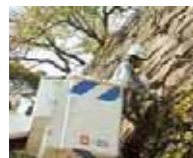
高所作業車を使った城壁清掃
