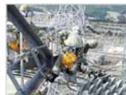
送電鉄塔・がいしの点検・修繕
