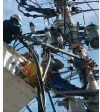
ケーブル末端部分の現場修理
