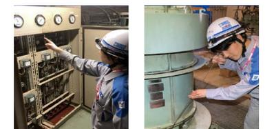
指差呼称による計器の確認 聴診棒による異音の確認
