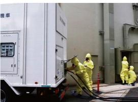
高圧発電機車の電源ケーブル接続
