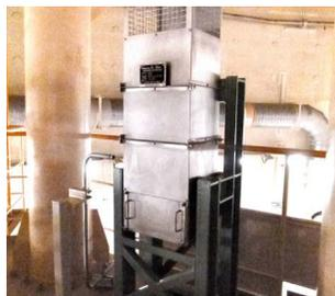
静的触媒式水素再結合装置
