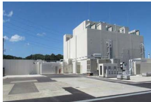
緊急時対策棟(川内)
