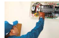
分電盤の点検
