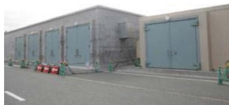
資機材等を収納する保管庫(玄海)
