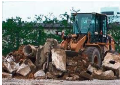
重機によるがれき撤去
