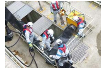
海水取水する水中ポンプの設置
