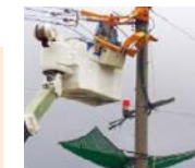
配電工事中の落下防止ネット使用
