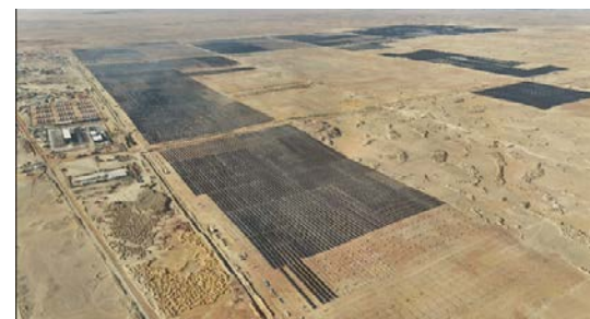
エジプト・アラブ共和国 太陽光発電 蓄電池事業(建設中)
