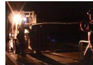
ホースの運搬・設置(夜間)
