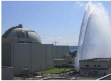
放水砲による放水
