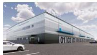
北九州市小倉南区物流施設 (2027年7月竣工)
