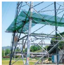
送電鉄塔の昇塔防止装置の設置
