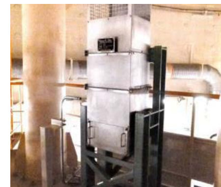
静的触媒式水素再結合装置
