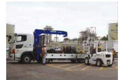
電源ケーブルの運搬
