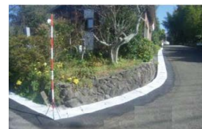
アクセス道路等の改善支援(側溝への蓋設置)
