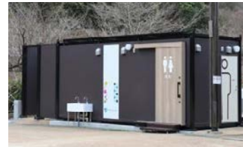
公園に設置、災害時に避難所へ移設可能
