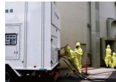
高圧発電機車の電源ケーブル接続
