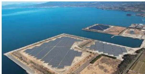
大村メガソーラー発電所
