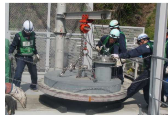
上蓋取替作業の様子
