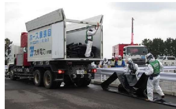
ホース敷設作業の様子
