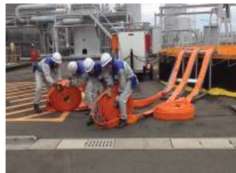
原子炉を継続して冷却するための仮設ポンプによる冷却水供給訓練
