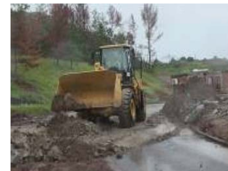
資機材の運搬ができるよう、がれきを撤去する訓練
