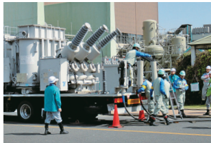
●移動用機器による電力供給訓練
