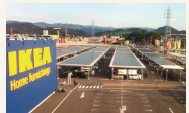
IKEA 福岡新宮(駐車場屋根) (設備買取方式)
