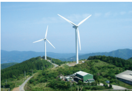
長島風力発電所
