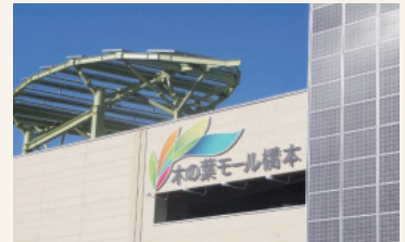
木の葉モール橋本 (エネルギーサービス方式)
