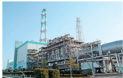
新大分発電所（LNG火力）
