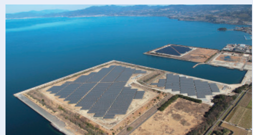
大村メガソーラー発電所
