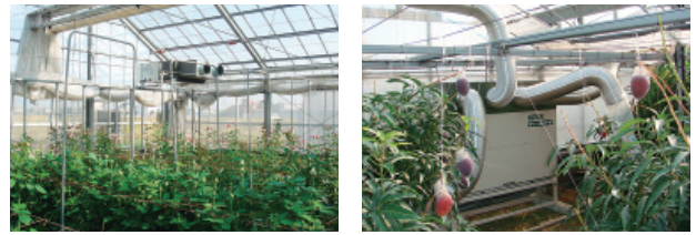
ヒートポンプ利用栽培(左：バラ栽培農家、右：マンゴー栽培農家)
