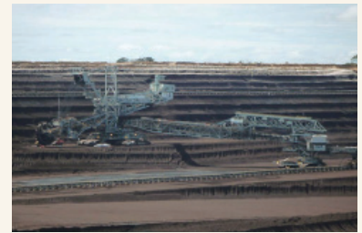
ビクトリア州褐炭採掘現場
