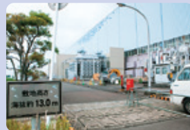
海拔13mのタービン建屋
