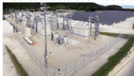
模擬配電線、電圧調整機器、蓄電池、太陽光パネル等
