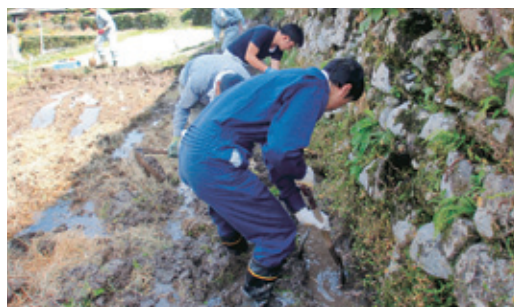
棚田の畦及び水路の復旧作業
