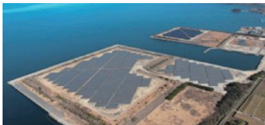
大村メガソーラー発電所
