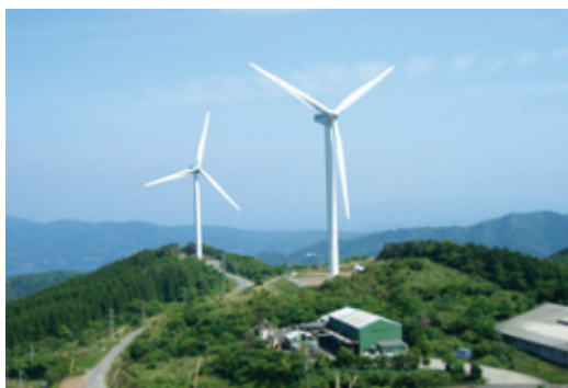
長島風力発電所
