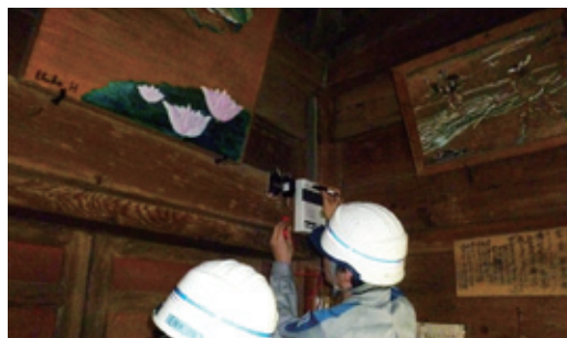
重要文化財配線診断(人吉営業所)
