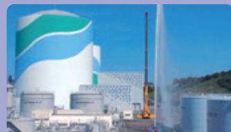
放水砲による放水試験
