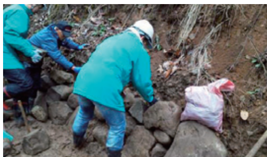
棚田の石積み復旧作業
