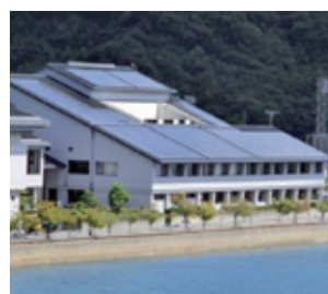
太陽光パネル(屋根設置)
