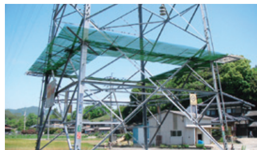
送電鉄塔の昇塔防止装置設置状況
