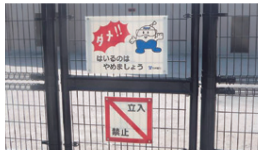
変電所の注意喚起標識設置状況
