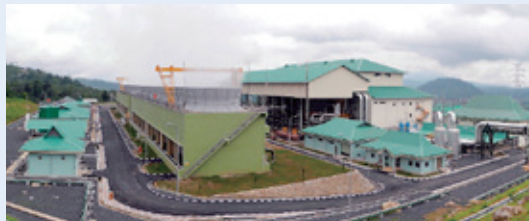
ウルブル地熱発電所(インドネシア)
