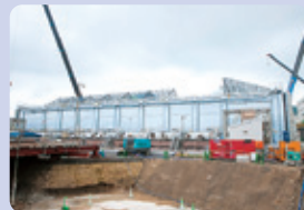
新設された防護壁
