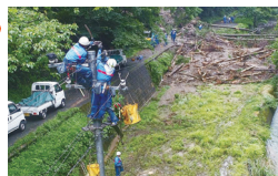
迅速な停電復旧（配電線路復旧）
