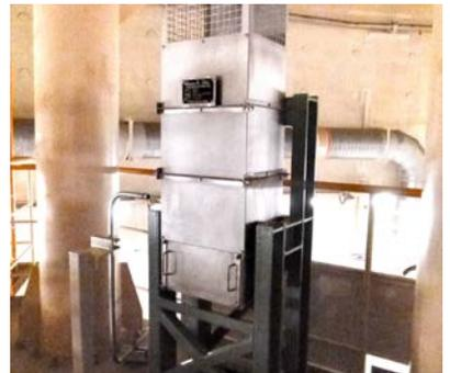
(\*1) 冷却水による熱交換で、格納容器内の空気を冷却する装置 (\*2) 触媒により、水素と酸素を反応させて水にする装置
