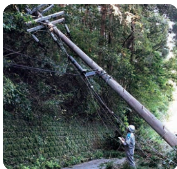
電柱折損復旧
