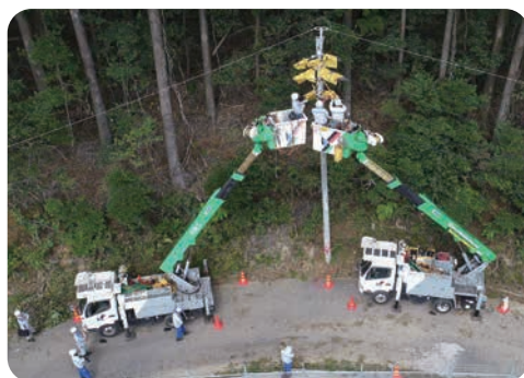
配電線路復旧
