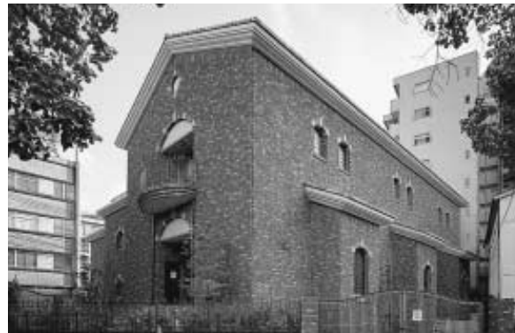
新地変電所(長崎市)
