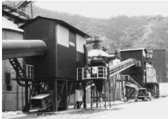
建設汚泥の固化処理プラント (「平成13年度リサイクルモデル工事」建設副産物リサイクル広報推進会議認定)
