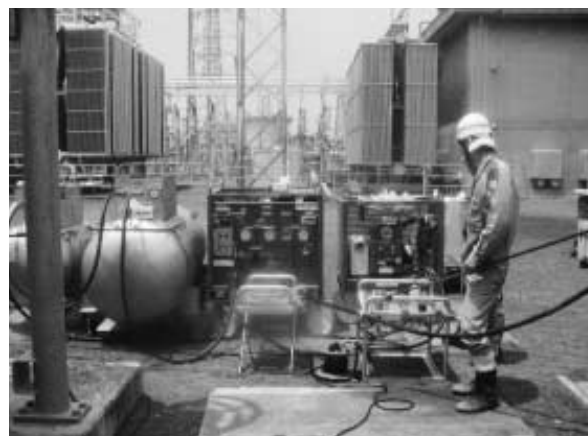
SF 6 ガス回収状況
