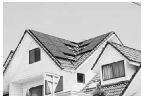
太陽光発電パネルの設置状況
