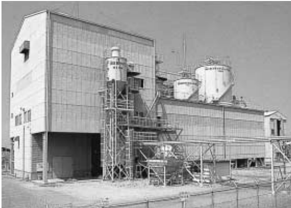
人工軽量骨材の製造装置
