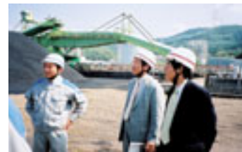
貯炭場の管理状況に関して環境管理者から説明 (松浦発電所)
