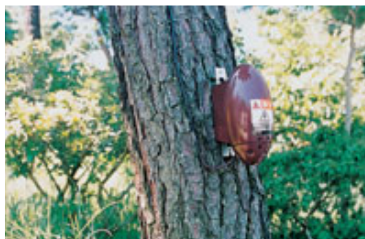
「松護郎」の取り付け状況
