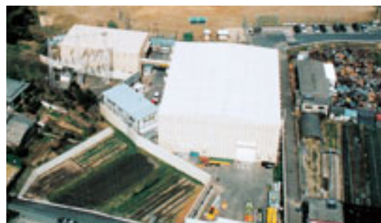
久留米分岐線新設工事のうちトンネル工事（発進立杭側）
