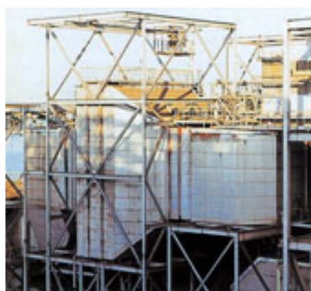
排煙脱硫装置
