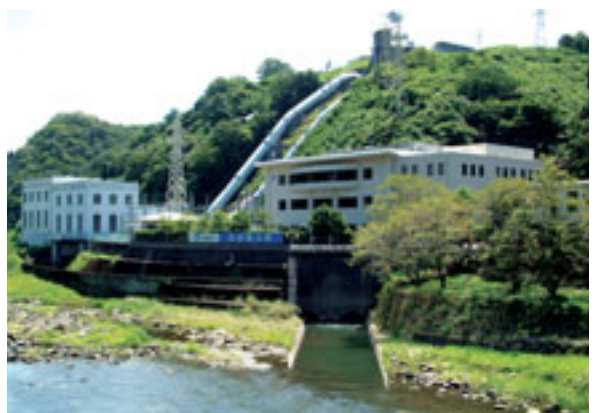
女子畑発電所(日田電力所)
