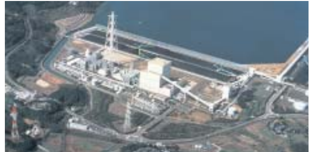
松浦発電所の全景 [電源開発株との共同立地(揚運炭設備、緑地等を共有)]
