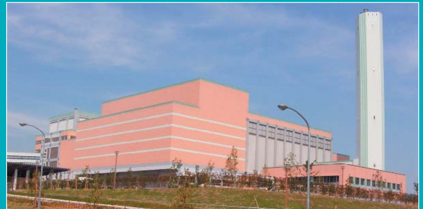
(株)福岡クリーンエナジー(東部工場)
