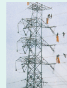
220kV送電線風音対策工事
