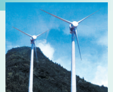
大分県前津江村椿ヶ花風力発電所(西日本技術開発(株)施工)
