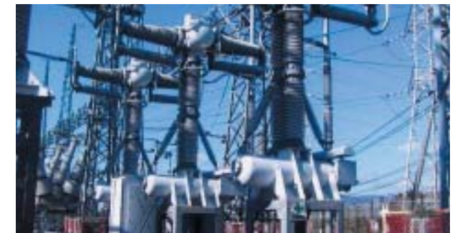
ガス絶縁開閉器
