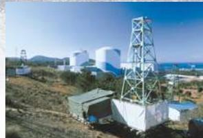
岩盤が原子炉建屋基礎として十分な耐震安定性を有することを確認するために実施しています。
