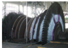
定期点検中の蒸気タービン
