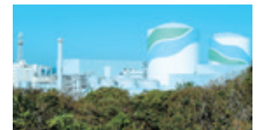
川内原子力発電所
