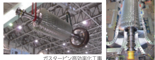
ガスタービン高効率化工事
