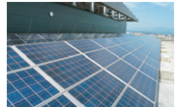
熊本支店屋上の太陽光発電設備
