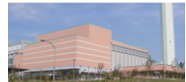
(株)福岡クリーンエナジー東部工場
