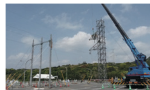
仮鉄柱組立・据付
