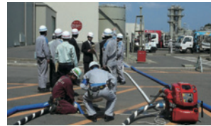
仮設ポンプ設営
