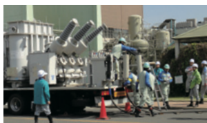
車載型移動用変圧器の接続
