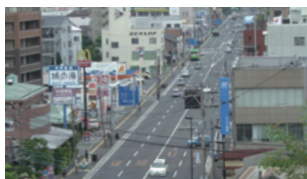
[無電柱化前] 熊本市内の地中化路線(2010年度整備)
