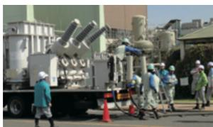
車載型移動用変圧器の接続
