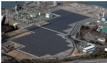
メガソーラー大牟田発電所
