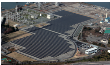
メガソーラー大牟田発電所
